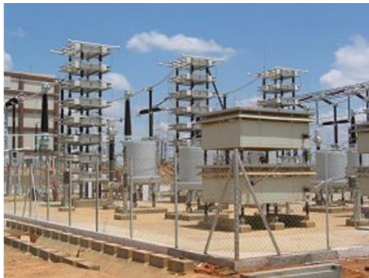
Slika 2.21. AC filteri [11]
