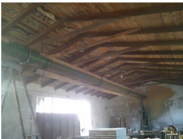
Slika 6.3. Cjev usisnog kanala za piljevinu
