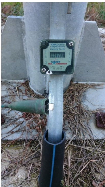
Slika 4.12. Spoj vodiča s uzemljivačem gromobrana MS2
