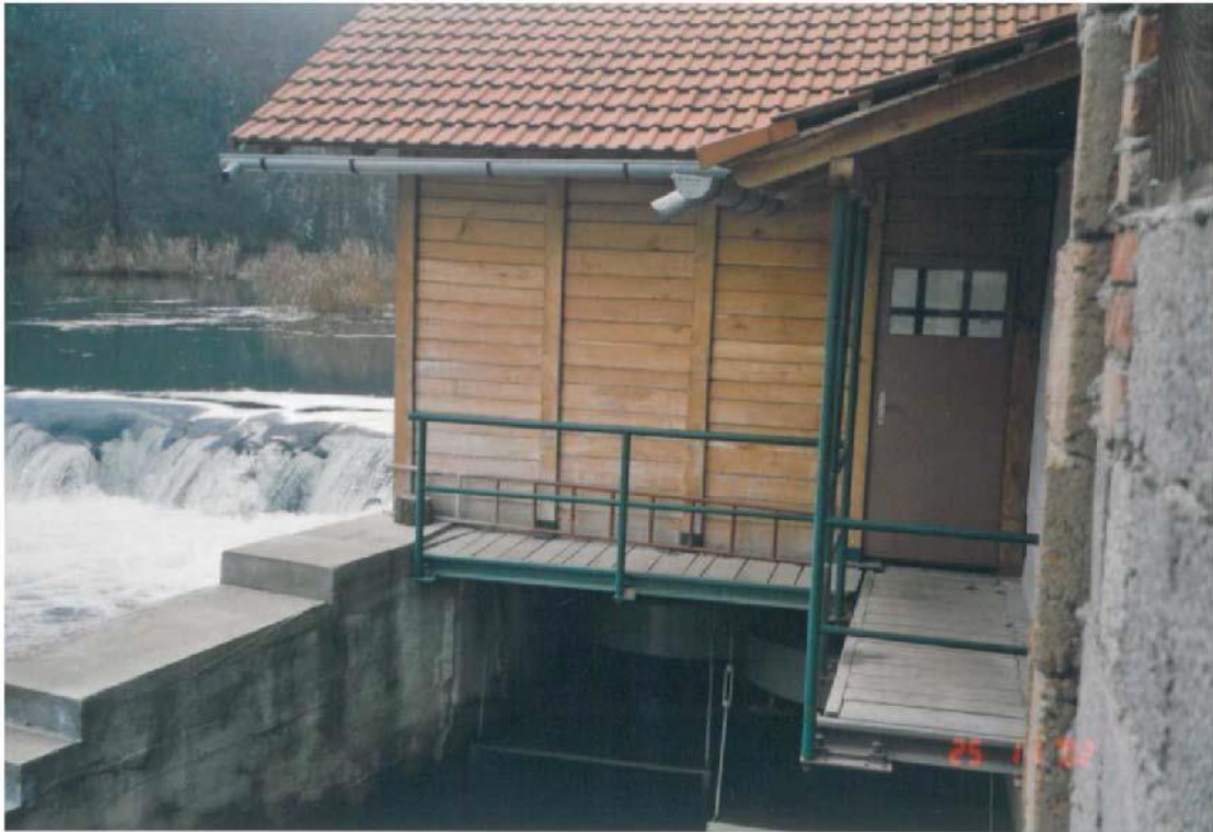
Slika 2.8. Mikro hidroelektrana Mataković, Mrežnica, instalirana snaga 15 kW [6]
