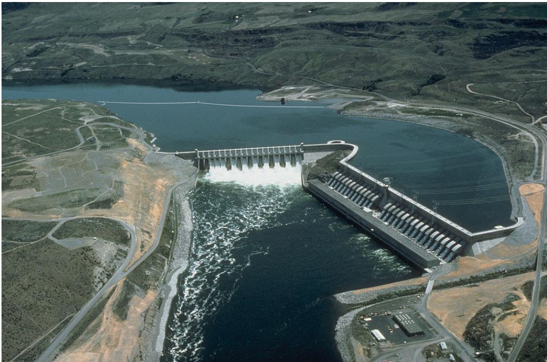
Slika 2.2. Protočna hidroelektrana [29]
