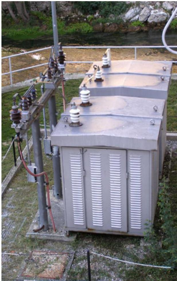
**Slika 4.8.** Maloomski otpornik za uzemljenje zvjezdišta  $35 \text{ kV}$  (HE Miljacka)
