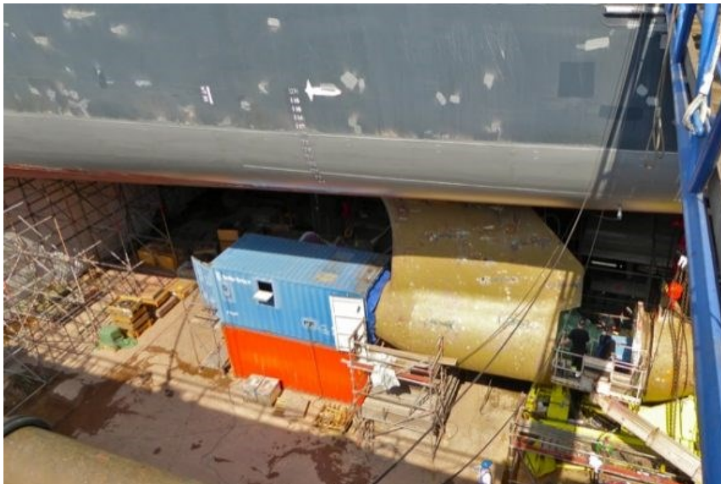
Slika 5.5.2. Rekonstrukcija FPP propelera firme Rolls Royce
