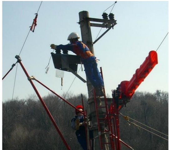
Sl. 3.12. Postupak zamjene izolatora metodom rada „u dodiru“ korištenjem: autoplatforme (lijevo) i izolacijskih ljestava (desno) [7]
