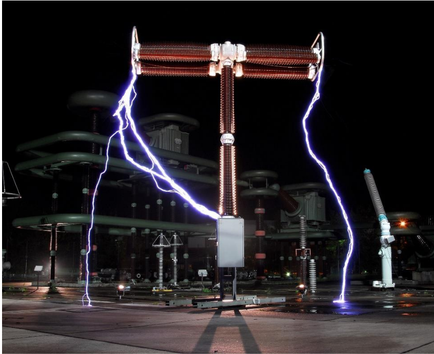
Slika 3.1. Prenaponsko ispitivanje 550 kV-nog VN prekidača
