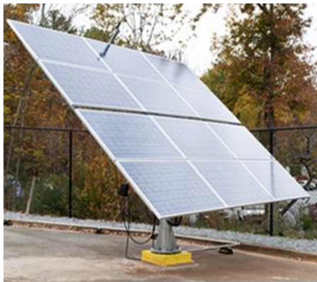
Slika 3.6. Izgled dvoosnog FN sustava s praćenjem Sunca [9]
