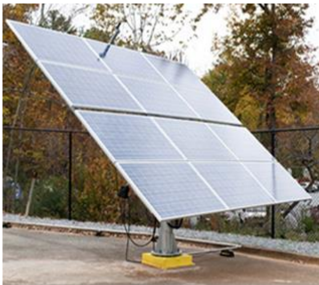
Slika 3.6. Izgled dvoosnog FN sustava s praćenjem Sunca [9]
