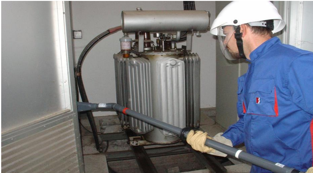
Slika 3.4. Čišćenje transformatorske prostorije u RPN [1]
