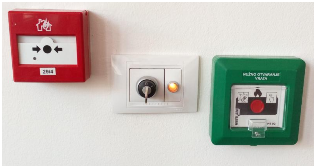
Sl. 5.3. IPR tipkala vatrodjave, nužnog otvaranje vrata i bravica sa ključem za servisno otvaranje vrata.
