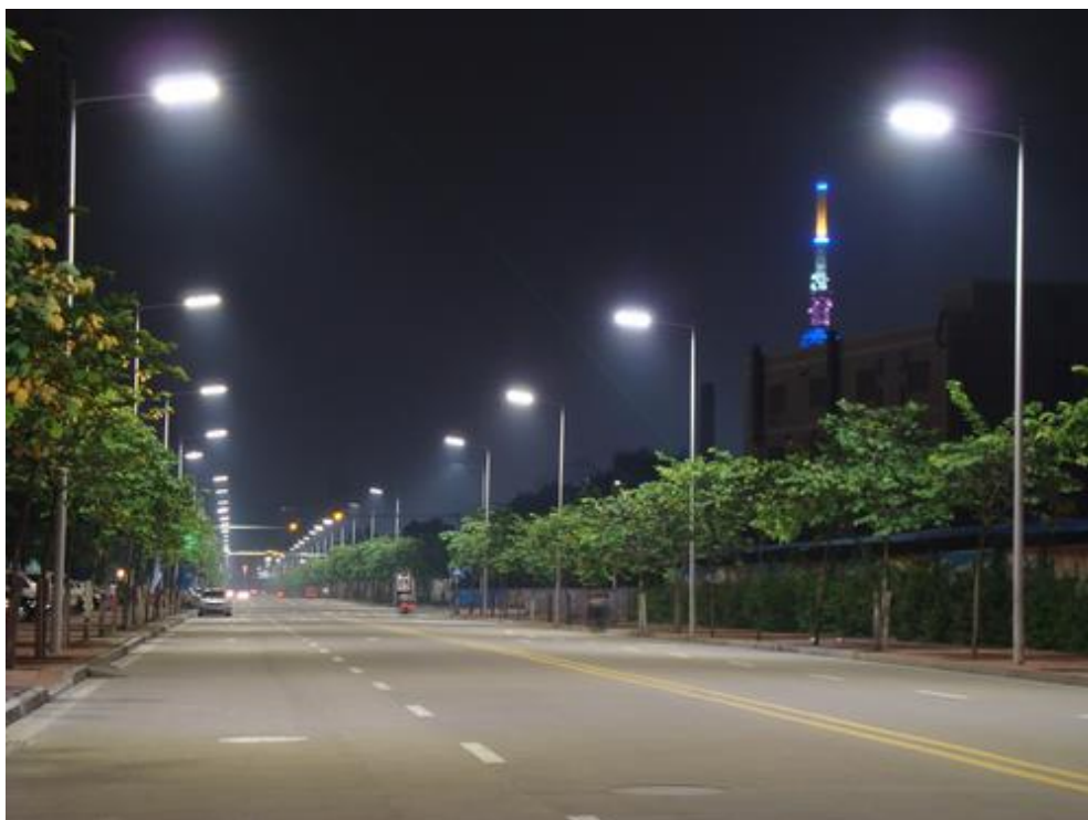
Slika(2.7.) Prometnica sa led rasvjetom[5]
