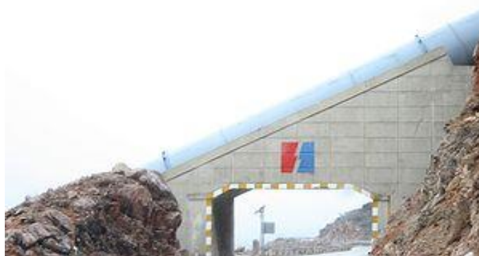
Sl. 2.3. Reverzibilna hidroelektrana Velebit [10]
