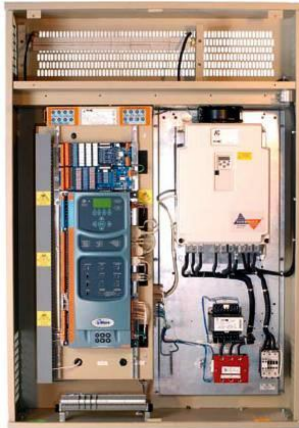
Slika 4.48. Mikroprocesorska upravljača jedinica [12]
