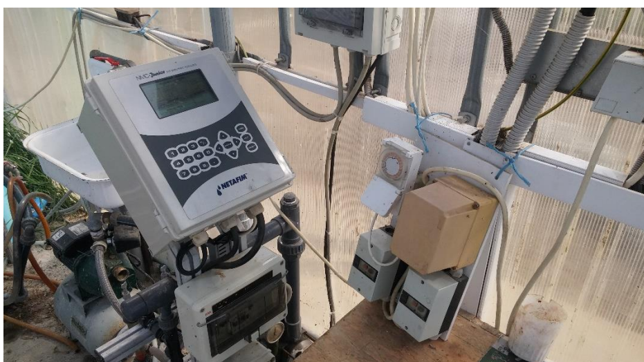
Slika 3.2. Upravljačka jedinica sustava NETAFIM NMC-Junior
