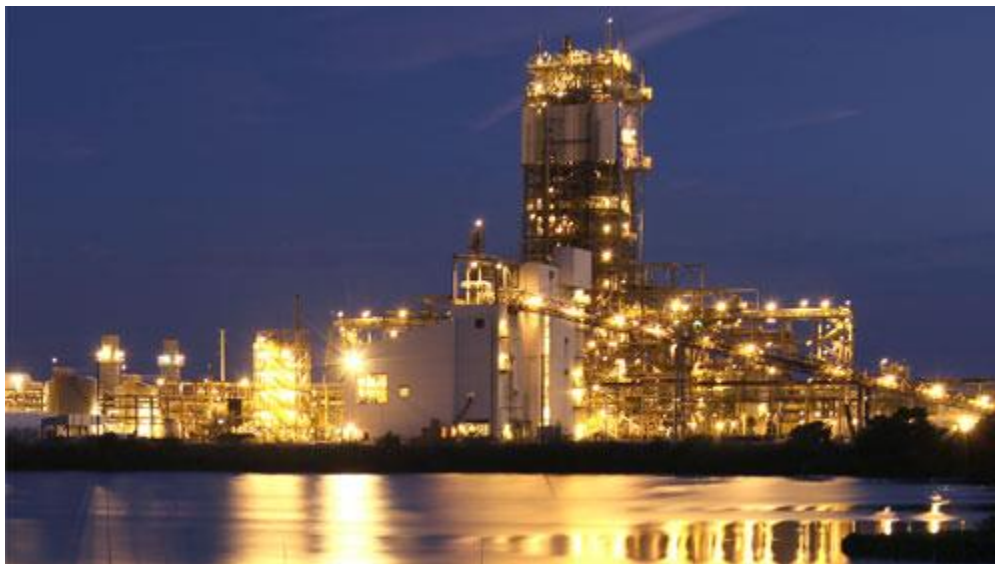
Sl. 2.8. Elektrana Tampa Electric's Power Station u Floridi, radi na plin dobiven od ugljena. [2]
