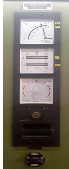
Slika 7.3. Oprema za vizualno praćenje sinkronizacije
