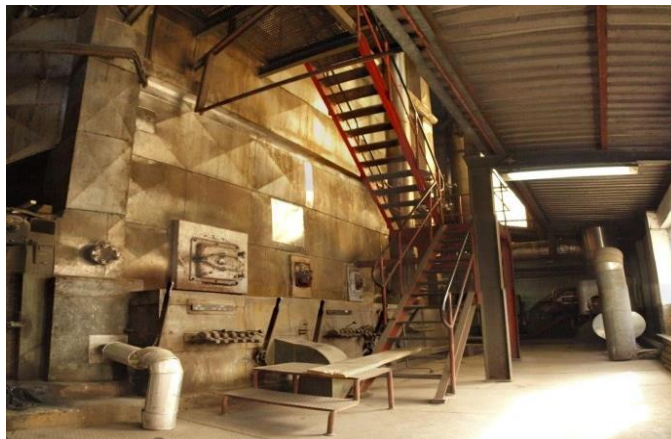
Slika 5.3. Ložište kotla 5568
