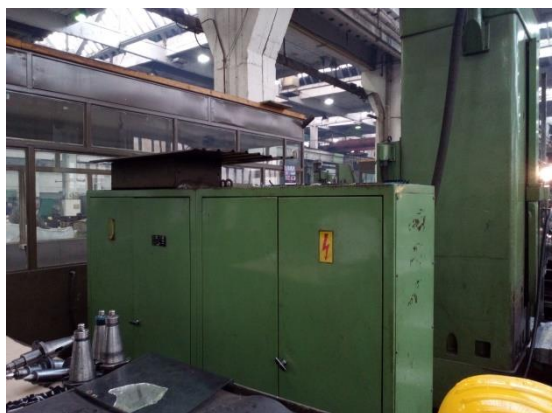
Slika 4.26. Strojni ormar, (Fotografirano 12.11.2016.)
