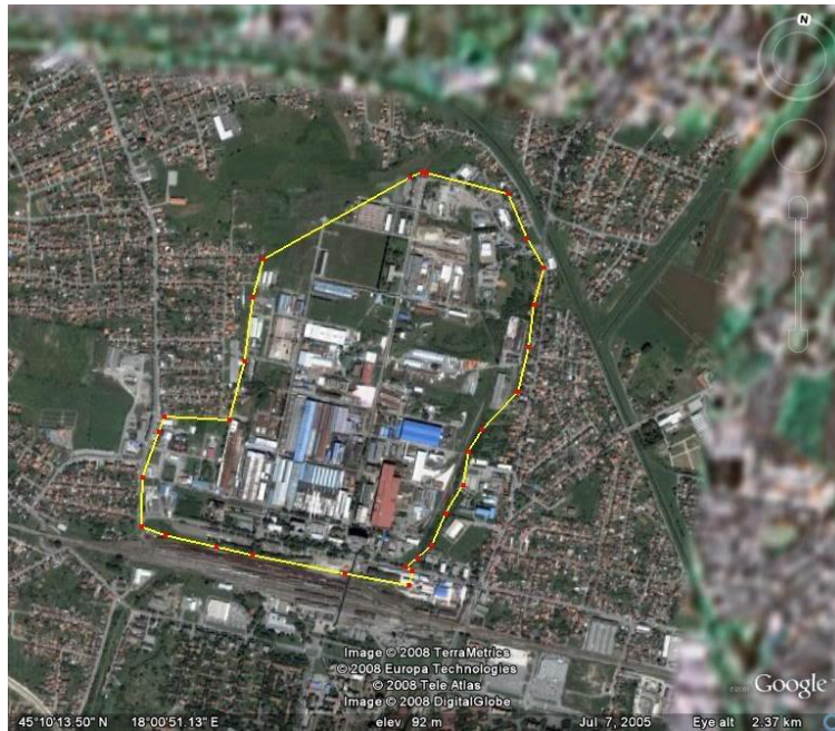
Slika 1.1. Izgled postrojenja Đure Đakovića, (Preuzeto iz [19])
