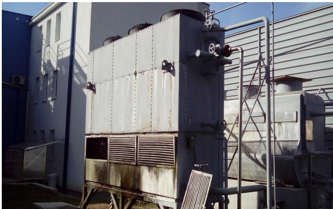
Slika 4.4. Evaporativni kondenzator
