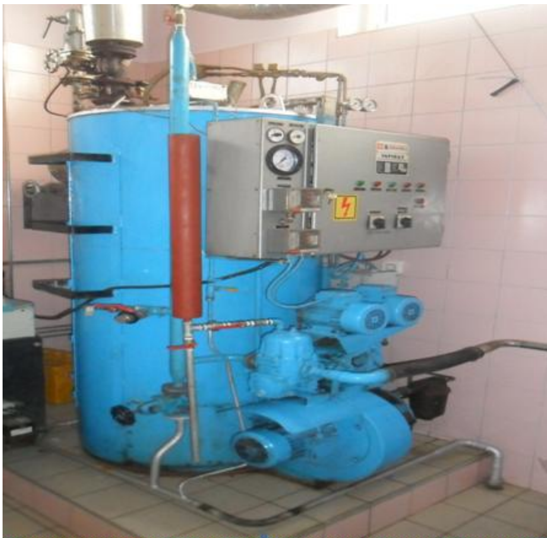
Slika 3.33. Kotao za proizvodnju pare VP-600
