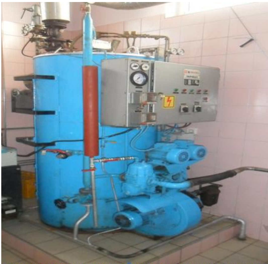
Slika 3.33. Kotao za proizvodnju pare VP-600
