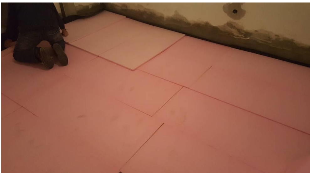
Slika 4.12. Postavljanje ekstrudirane polistirenske pjene
