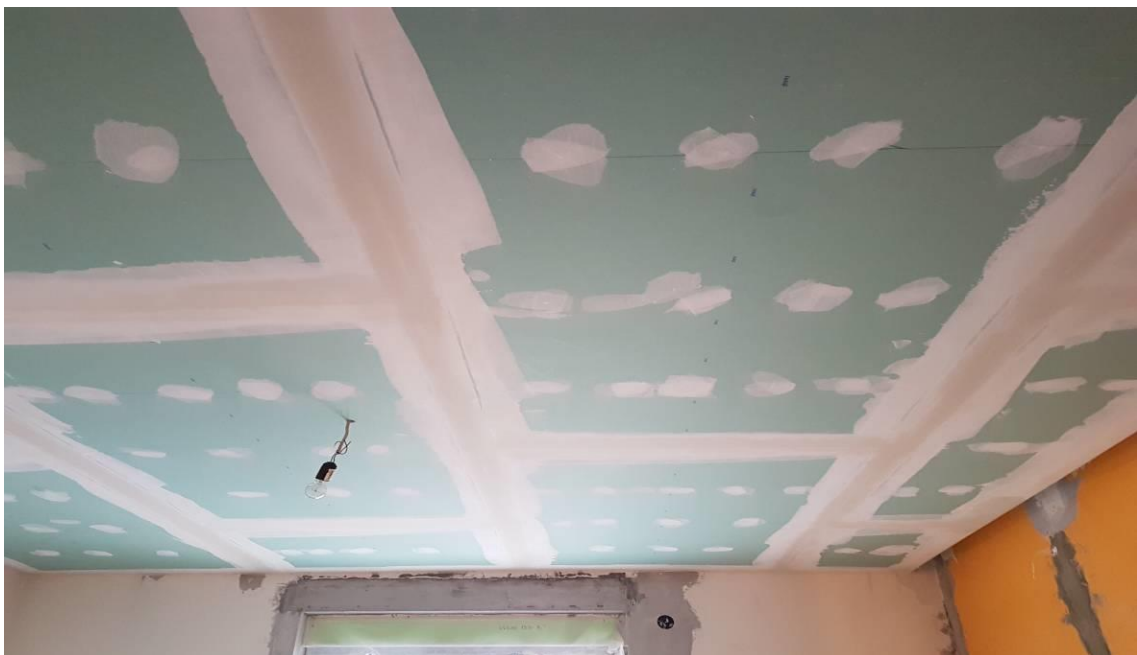
Slika 4.8. Postavljanje vodonepropusnih gipskartonskih ploča
