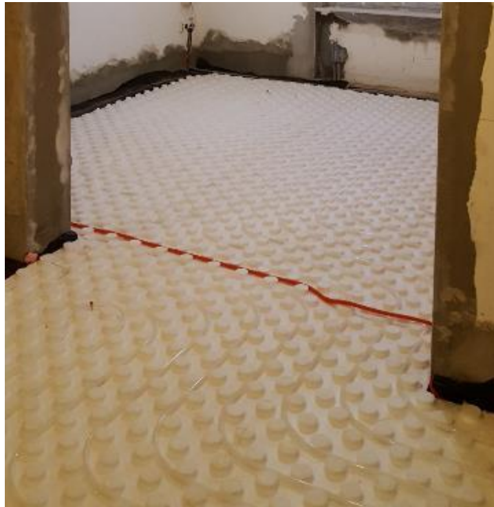
Slika 4.13. Postavljanje rastera za podno grijanje od ekspandiranog polistirena
