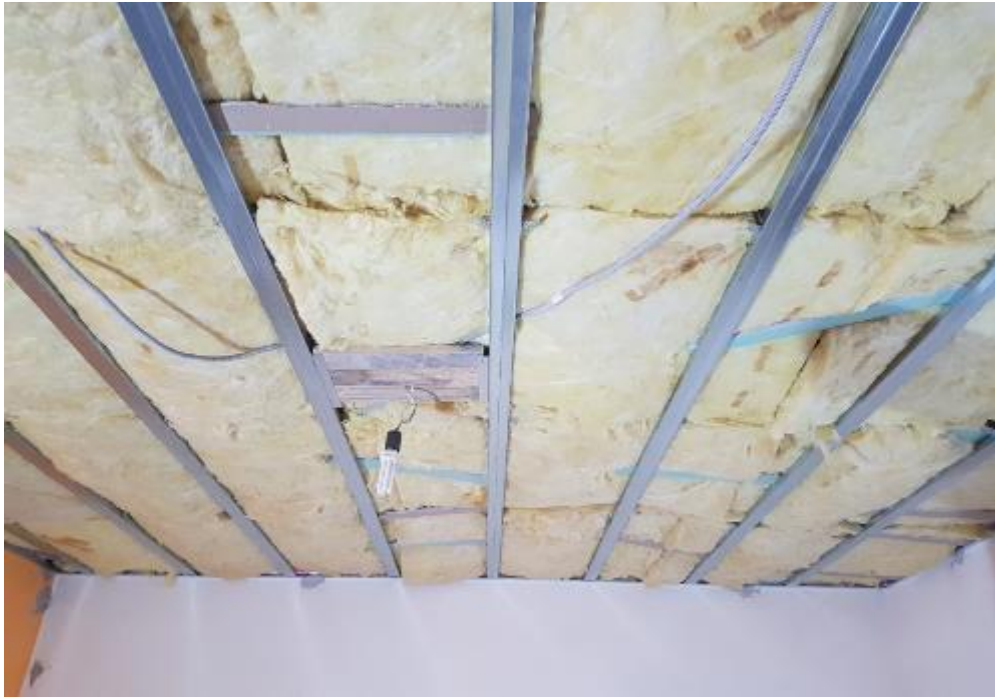
Slika 4.5. Postavljanje mineralne staklene vune prema HRN EN 13162
