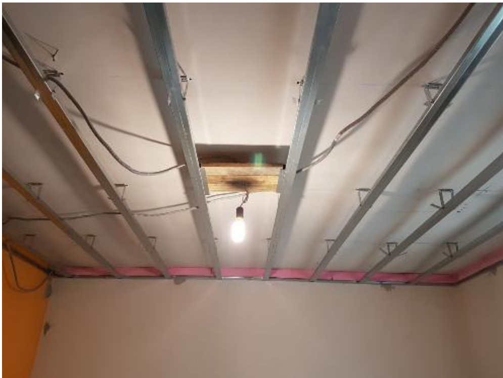
Slika 4.4. Postavljanje metalne konstrukcije
