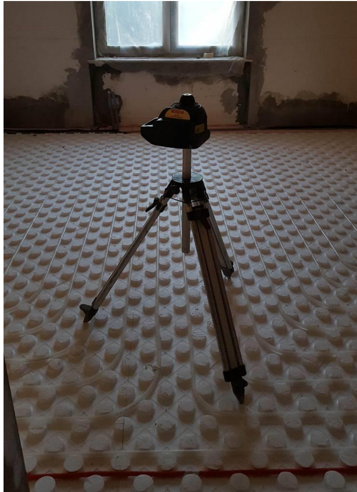
Slika 4.14. Laserski uređaj za određivanje „vagrada“ tj. referentne linije za određivanje visine estriha
