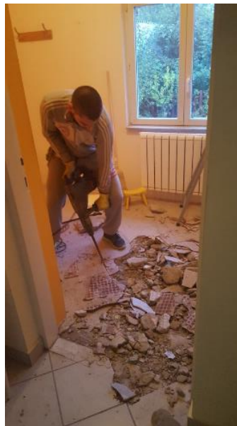
Slika 4.10. Uklanjanje postojećeg poda
