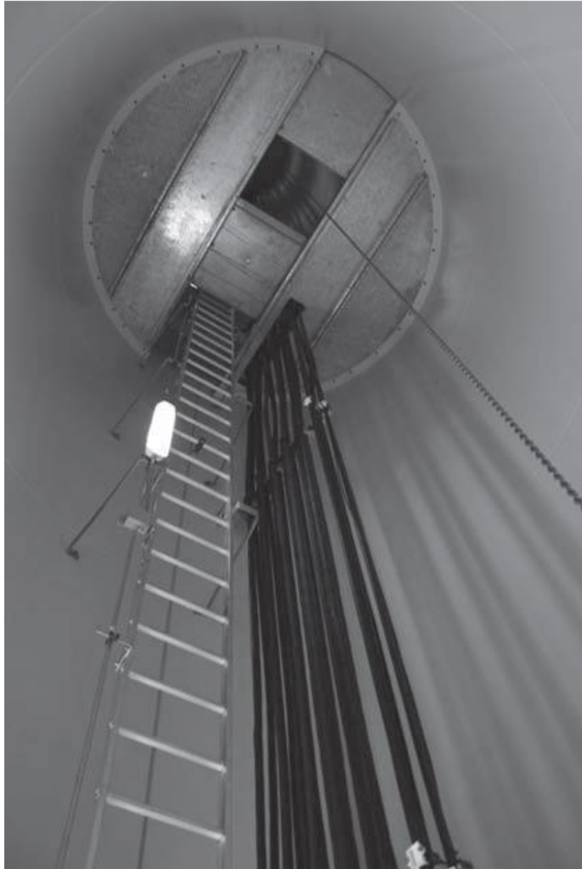
Slika 4.4: Ljestve i kablovi unutar cjevastog stupa. Preuzeto iz (Hemami, 2012).
