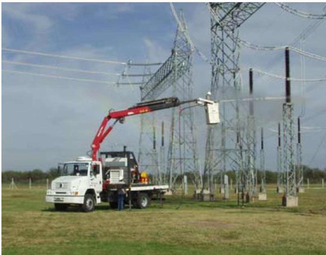
Sl. 3.12. Pranje izolatora s autoplatforme [5].
