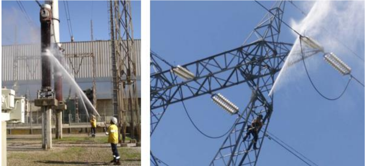
Sl. 3.19. a) Pranje sa zemlje u trafostanicama, b) Pranje sa stupa [12].
