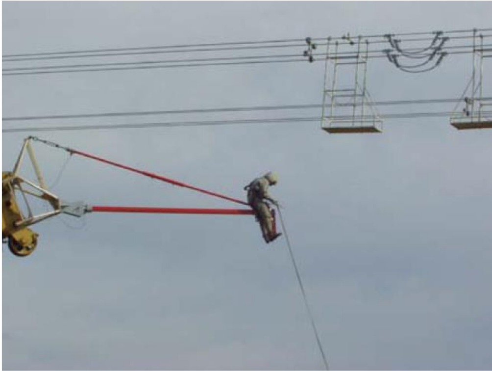
Sl. 3.10. Postavljanje radnika na potencijal vodiča pomoću dizalice [5].
