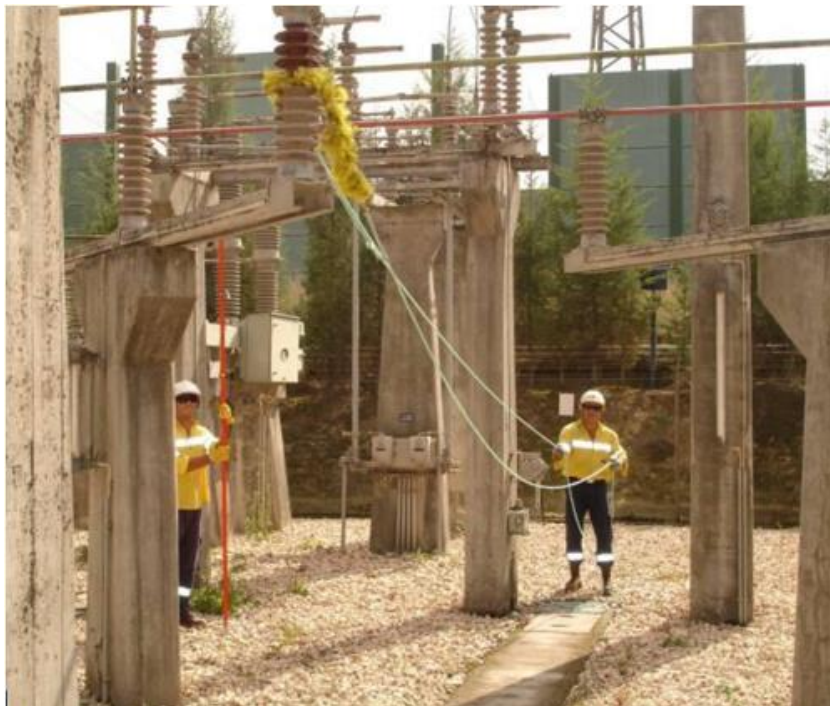
Sl. 3.18. Suho čišćenje izolatora [11].
