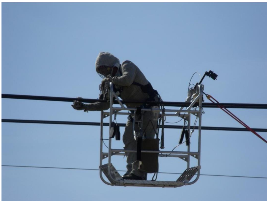
Sl. 6.2. Zamjena odstoynika na prijenosnoj mreži uz pomoć mobilne korpe [23].
