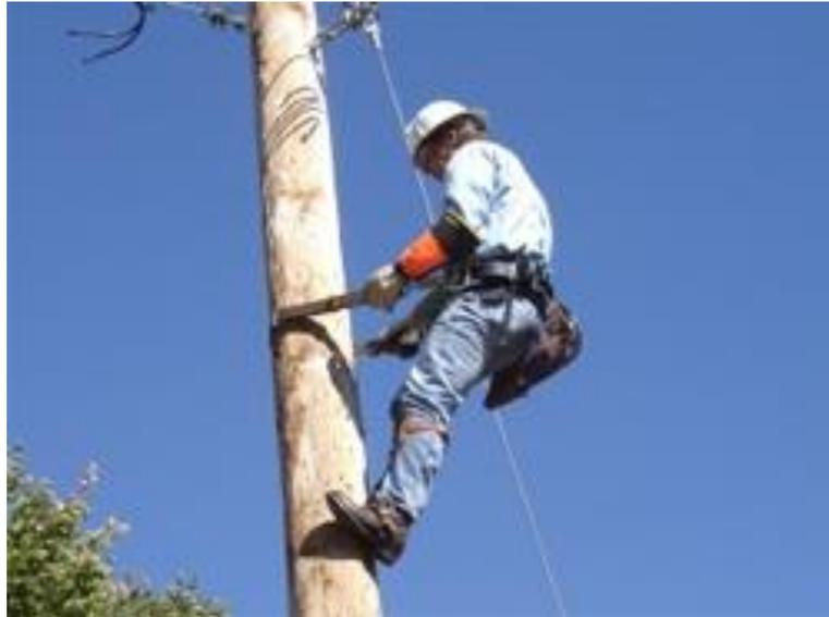
*Sl. 5.5. Oprema za pozicioniranje montera [20].*
