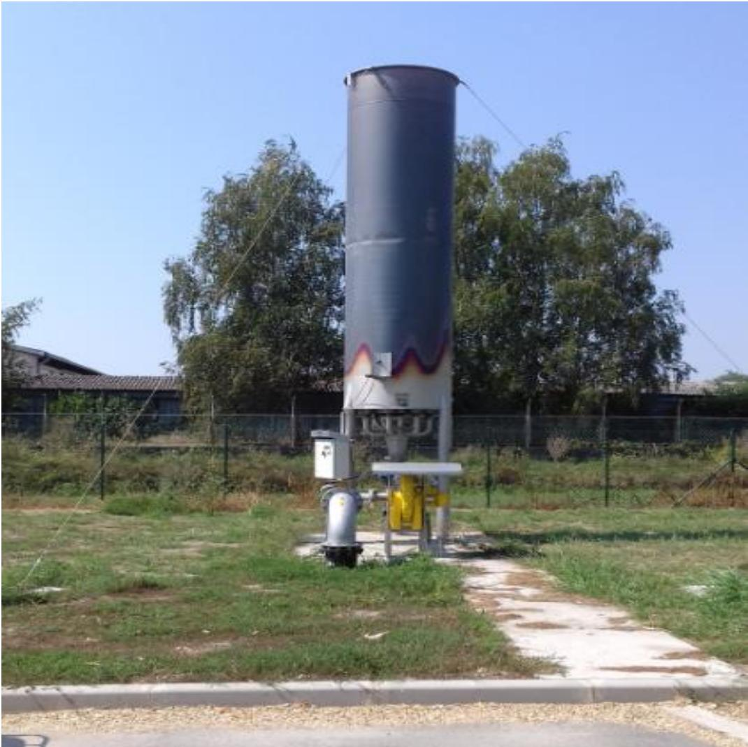
Slika 3.7. Baklja za spaljivanje bioplina [fotografirano 23.8.2018. u Osijeku]
