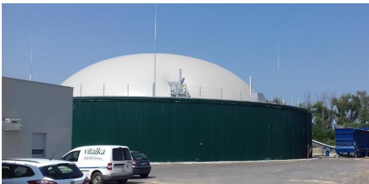
Slika 3.5. *Digestor ili fermentor* [fotografirano 23.8.2018. u Osijeku]
