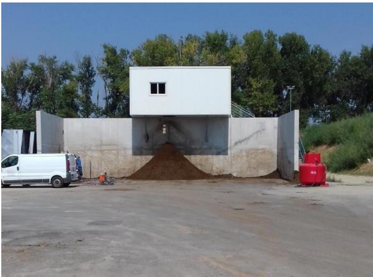
Slika 3.8. *Separator digestata* [fotografirano 23.8.2018. u Osijeku]
