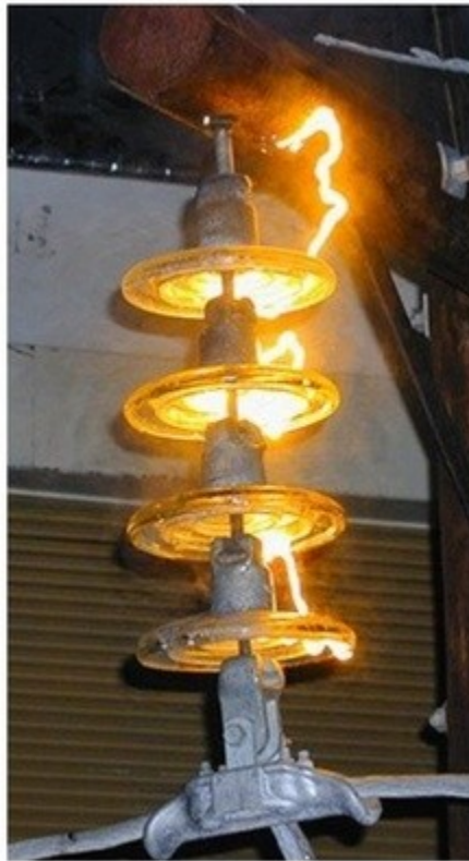
Sl.3.2.1. Proboj izolacije tijekom ispitivanja onečišćenjem
