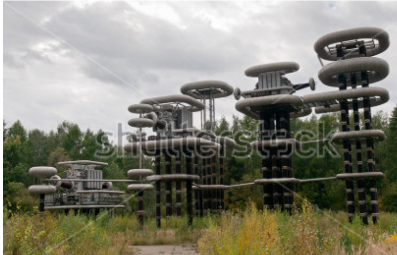
Sl.5.1.6. Najveća svjetska transformatorska kaskada 3MV/4,2A
