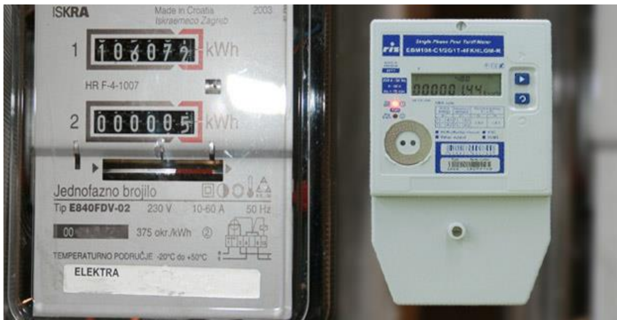
Slika 3.5. Prikaz elektromehaničkog i pametnog brojila [12]
