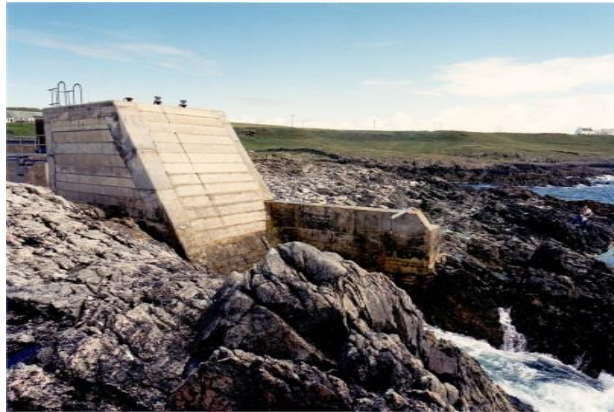
Sl. 3.4. OWC prototip 75 kW Islay, Škotska [9]
