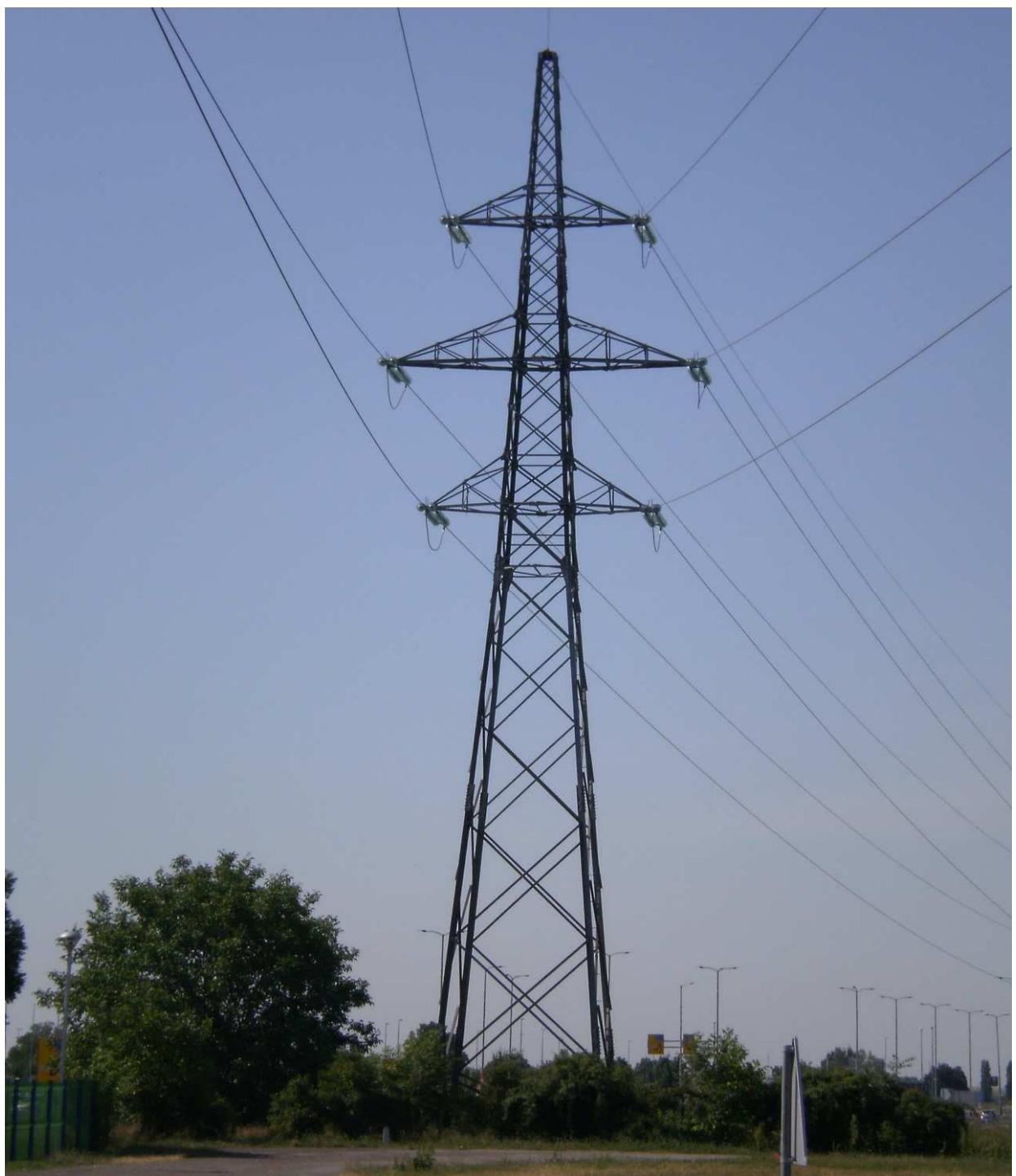
**Sl. 2.14.** Dvostruki čelično-rešetkasti stup 110 kV
