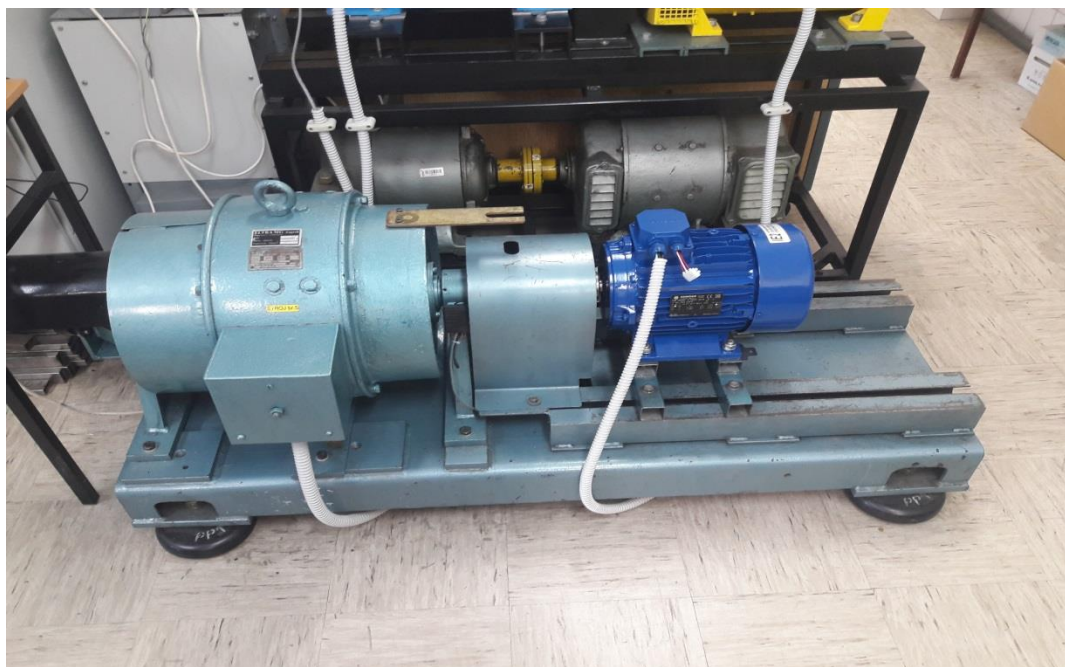
Slika 4.5. Ispitivani asinkroni stroj (desno) terećen istosmjernim generatorom (lijevo)
