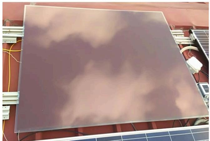
**Slika 3.2.** *Solarni modul- amorfni silicij, tankoslojni*
