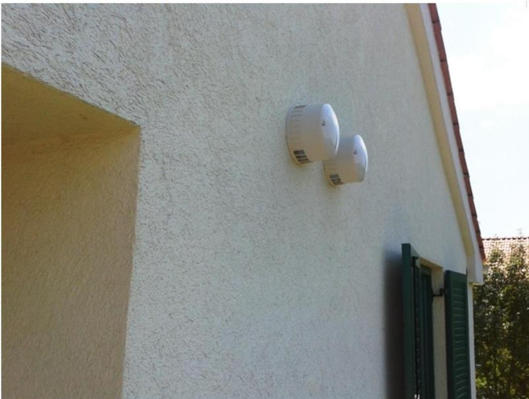
**Slika 3.26** Finalni izgled rekuperatora s vanjske strane
