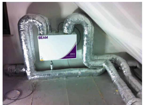
**Slika 3.15**Četiri odvojena kanala za zrak[14]
