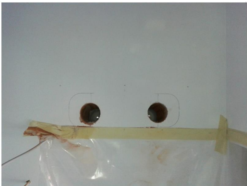
Slika 3.23 Bušenje usisnog i odsisnog ventilacijskog kanala
