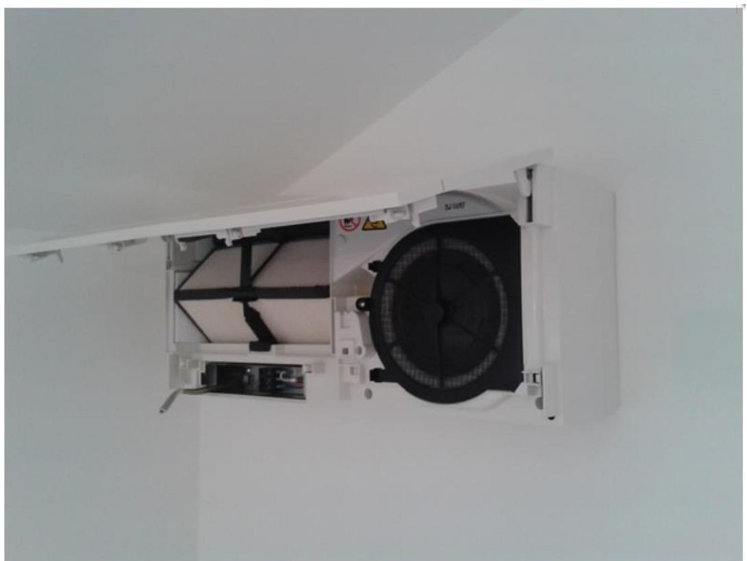
**Slika 3.27** Otvorena montirana unutarnja rekuperacijska jedinica
