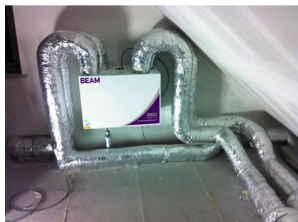
Slika 3.15 Četiri odvojena kanala za zrak [14]
