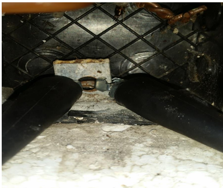
Slika 4.11. Spajanje u kutiji kada je uzemljivač odvojen od nule
