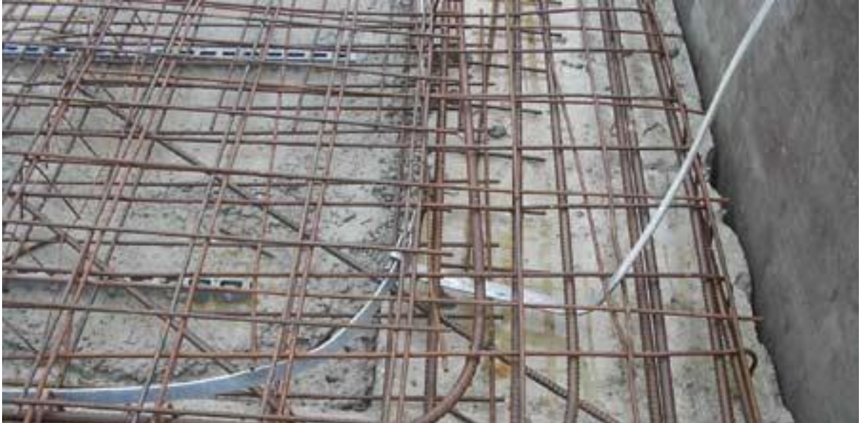
Slika 2.13 Temeljni uzemljivač[7]
