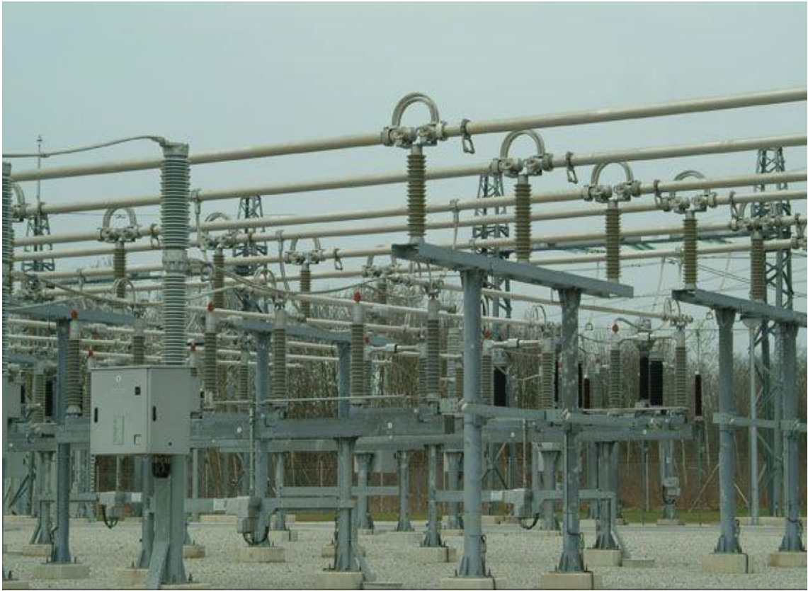
Slika 3.11. Diskontinuirane cijevi sabirničkog sustava [6]
