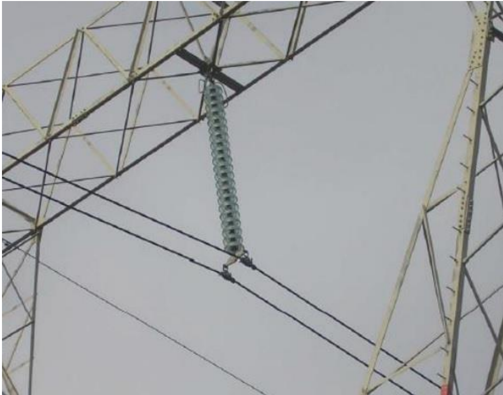
Slika 4.3. Štapni izolator [4]
