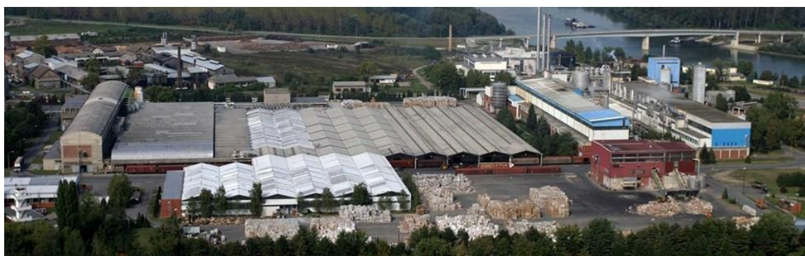
Slika 3.3. Pogon tvornice DS Smith u Belišću [4]
