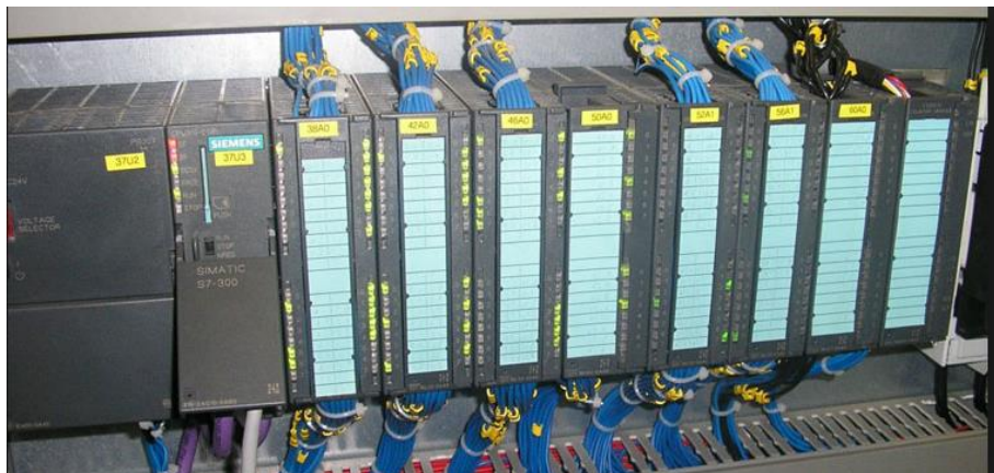
SI 3.1.1. Programabilni logički kontroler. [13]
