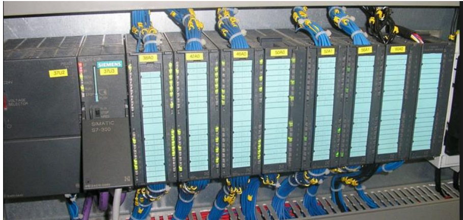
SI 3.1.1. Programabilni logički kontroler. [13]
