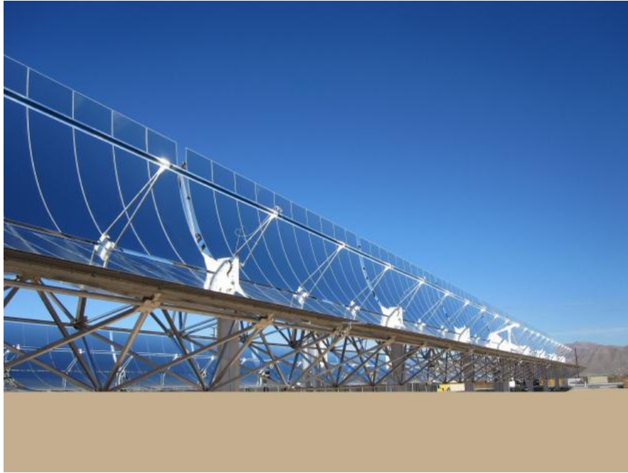
Slika 3.18. Parabolični kolektori[22]
