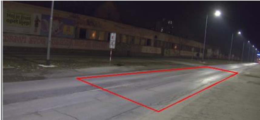
Slika 63. Luminacija između dva rasvjetna stupa, 2,49 cd/m 2 [91]
