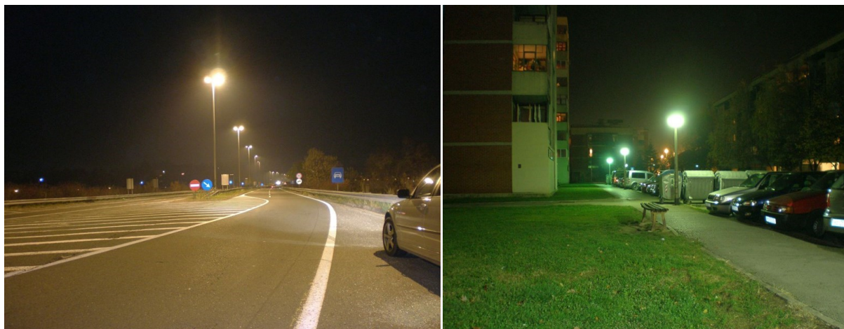
Slika 4.9. Rasvjeta prije realizacije projekta energetske učinkovitosti javne rasvjete u gradu Karlovcu [8]
