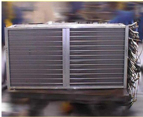
Slika 4.7. Prikazuje uspravnu izvedbu rekuperacije zraka pomoću toplinskih cijevi i izgled u praksi. Veći broj cijevi omogućuje i veću učinkovitost sustava što rezultira većim povratom topline, [12].
