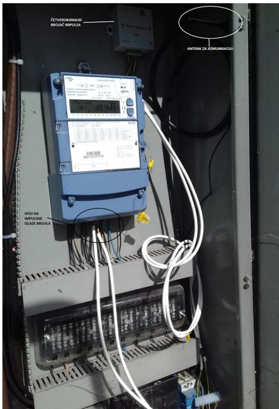
Slika 4.8. Spajanje na brojilo
