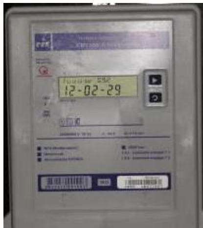
Slika 3.6. Prikaz trofaznog četverotarifnog brojila proizvođača Riz
