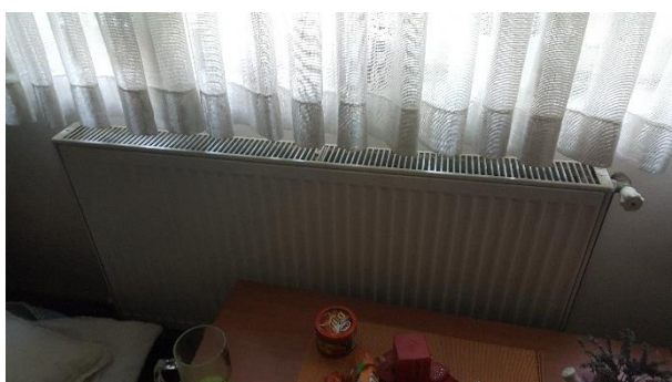
Slika 4.35. Jedan od aluminijских radijatora.
