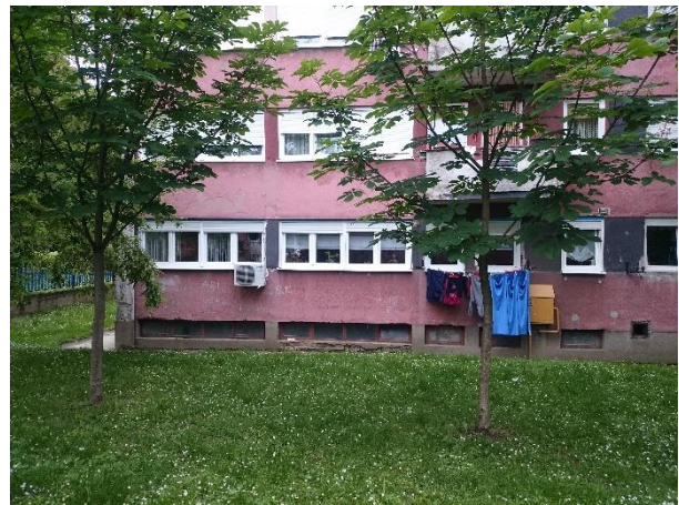
Slika 4.4. Zapadno pročelje zgrade.
