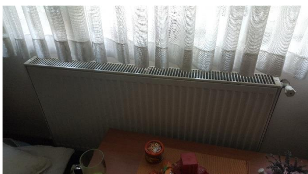
Slika 4.35. Jedan od aluminijских radijatora.
