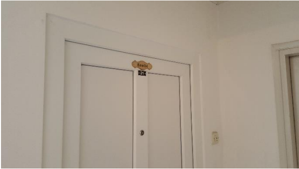
Slika 4.13. Karakteristični otvor zgrade PVC-PVC (ulazna vrata stambenog prostora).
