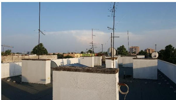
Slika 4.7. Ravni krov zgrade.
