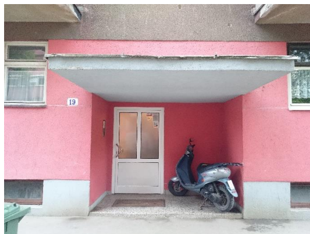
Slika 4.20. Ulazna vrata zgrade PVC-PVC.
