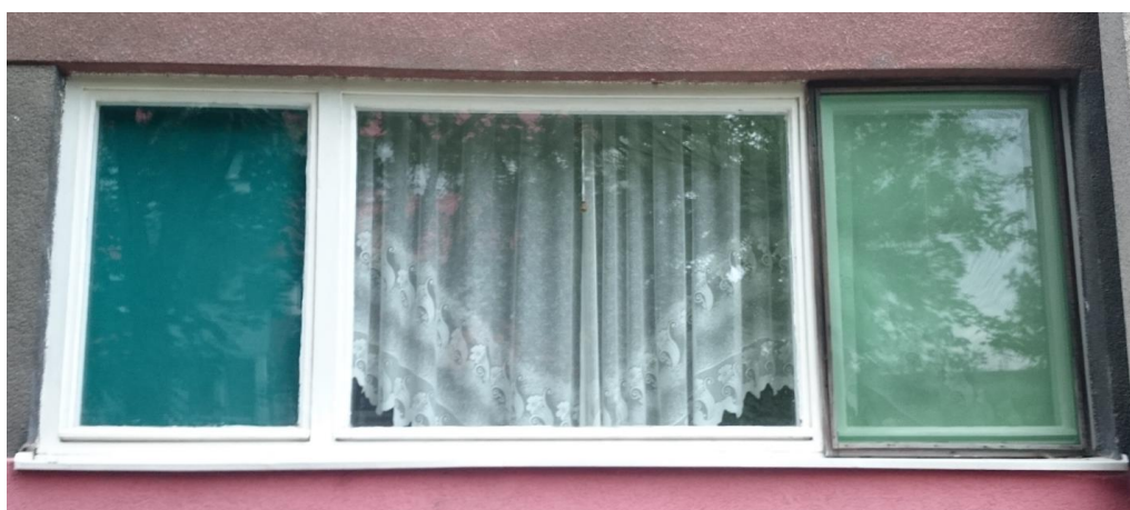
Slika 4.64. Prikaz karakterističnog postojećeg otvora na kojem će se implementirati mjera.
