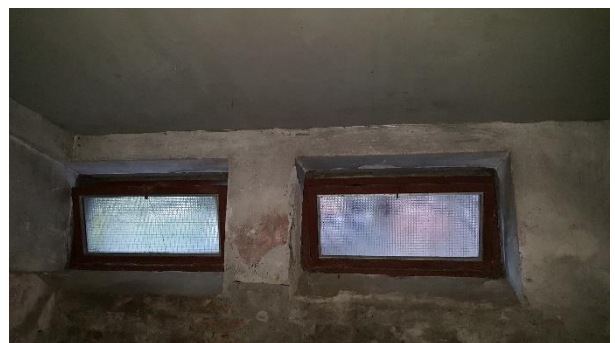
Slika 4.12. Karakteristični otvor zgrade M-JED (prozor podruma).
