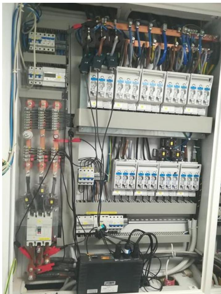
**Slika 6.2.** prikaz na koji način je izvršeno spajanje strujnih kliješta i naponskih stezaljki na vodove elektrane u glavnem razvodnom ormaru.
