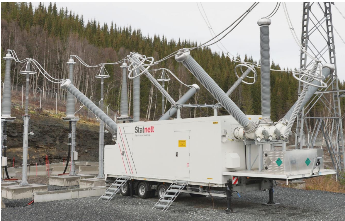
Slika 8.4 Mobilni GIS tvrtke ABB. [6]
