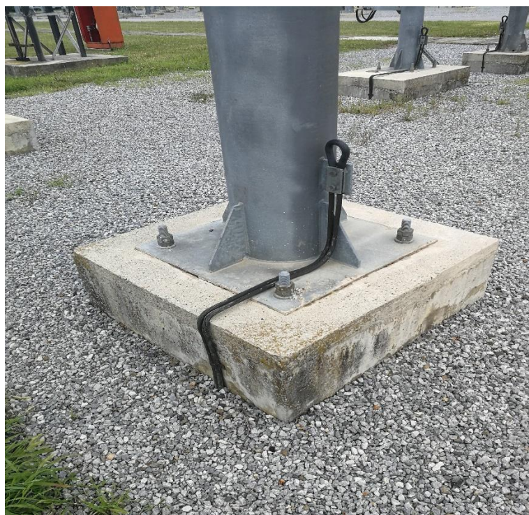
Slika 4.14. Uzemljenje stupa
