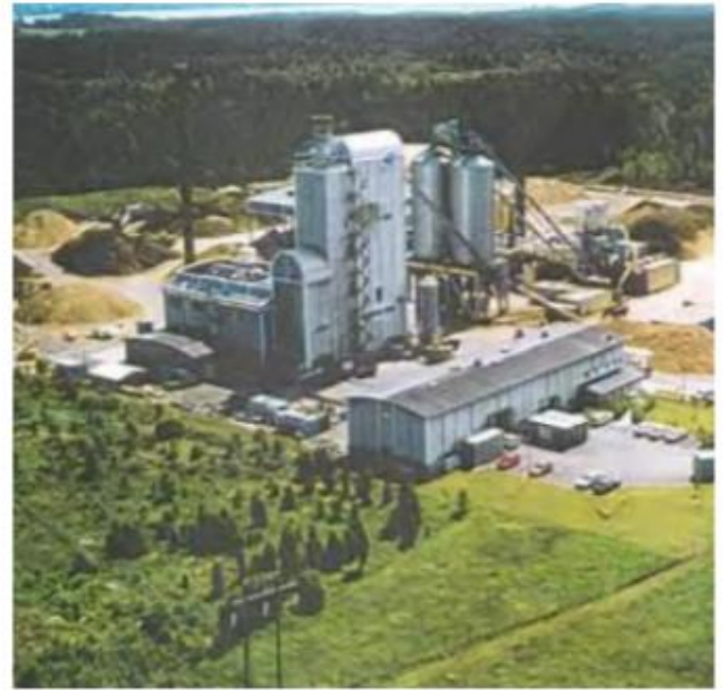
Finska kogeneracija VN, 49 (167) MW
