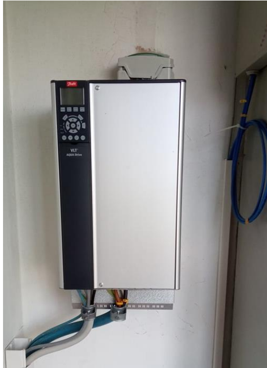
Sl. 4.10. Danfos frekvencijski pretvarač
