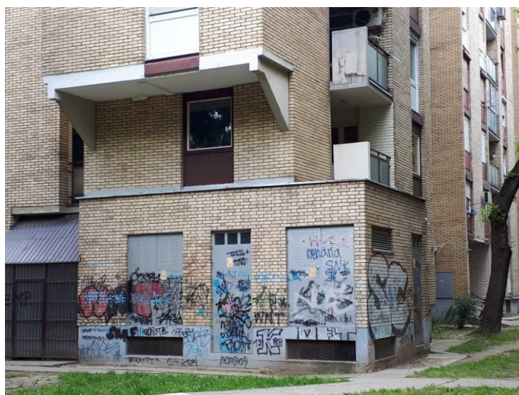
Slika 2.6. Distributivna trafostanica ugrađena u zgradu
