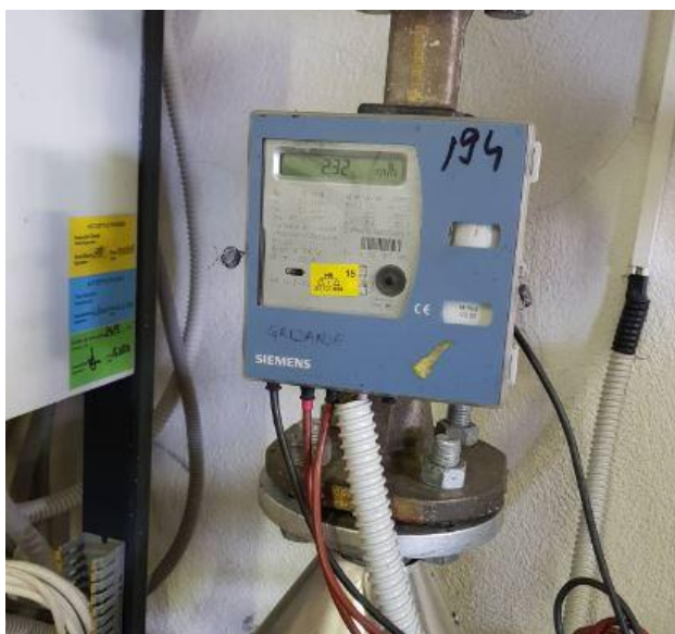
Slika 5.1. Kalorimetar Siemens RVD250.
