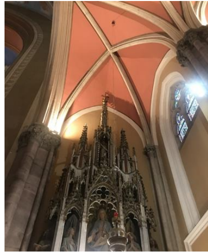
Slika 6.3. Postojeća rasvjeta (pogled na bočni oltar)
