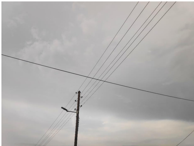
Slika 3.1. Prijelaz nadzemnog prijenosnog vodiča iznad telefonskog kabela
